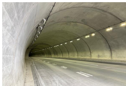
西脇北バイパストンネル照明LED化
