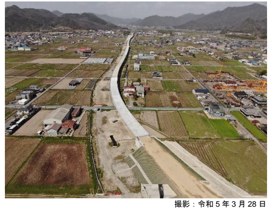
② 津方ランプ～津方高架橋
