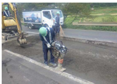
施工イメージ（路盤打換工）
