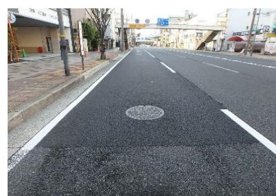
施工イメージ（切削オーバーレイ工）
