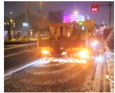
除雪作業（凍結防止剤散布）
