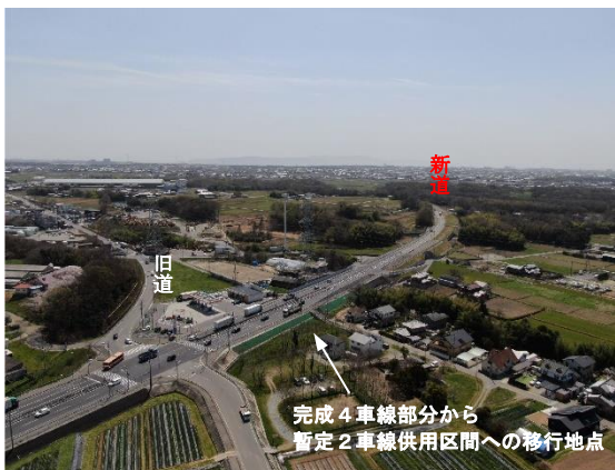
③ 暫定 2 車線供用区間 (ひろたに地区) 撮影：令和 5 年 3 月 29 日
