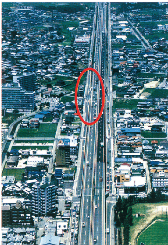
加古川東ランプ(下り)ONランプ改良前
