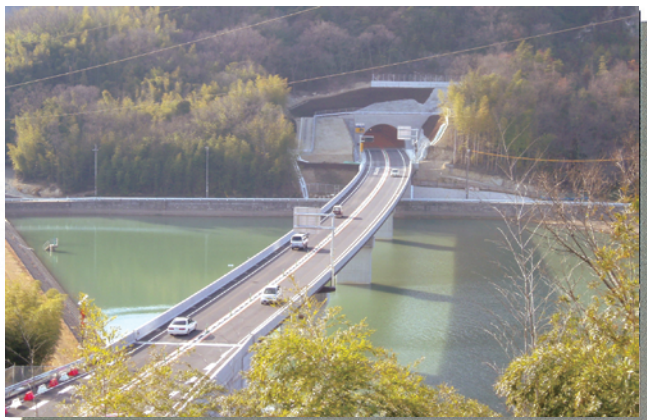
▲峯相大橋から石倉トンネル起点側を望む（平成23年3月27日撮影）
