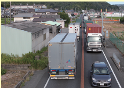
野々原交差点付近(供用前) 幅員が狭く大型車の擦れ違いが危険
