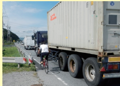
福井交差点付近(供用前) 車両と歩行者・自転車の通行が接近して危険
