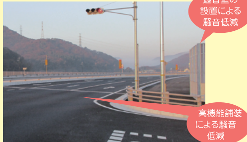
福井交差点付近(供用後)
