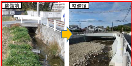
橋梁改築(山根川)(兵庫県)
