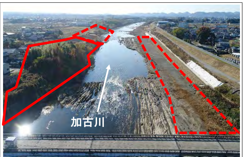
引き続き、樹木伐採、河道掘削を実施
