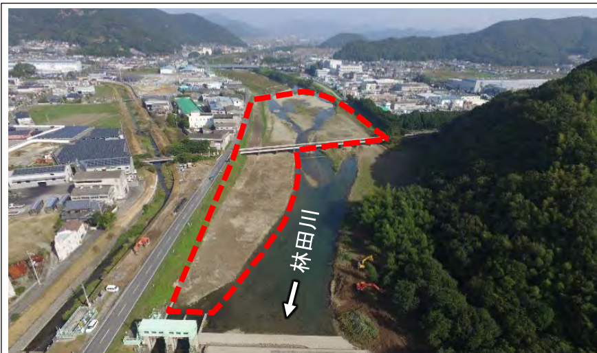
樹木伐採、河道掘削が完了
