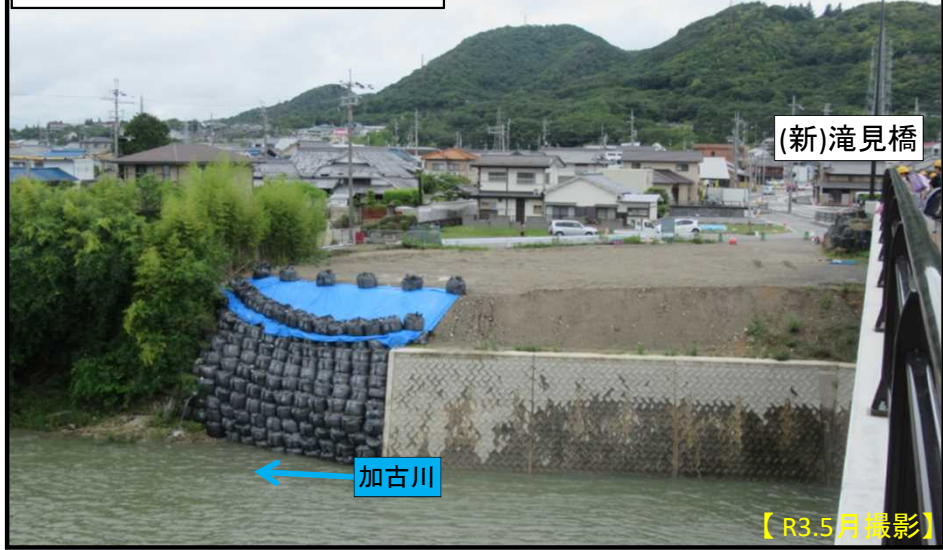
仮設護岸復旧完了
