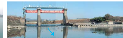
河合頭首工（加古川 28.3k 付近）
