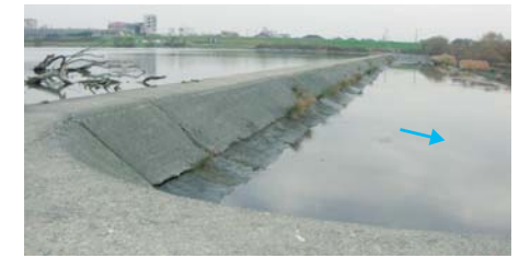
古新堰堤（加古川 3.8k 付近）
