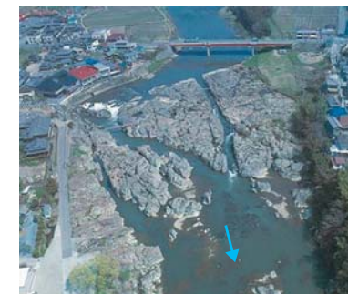
闘龍灘（加古川 35.0k 付近）
