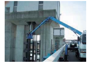
加古川大堰点検の様子（加古川 12.0k 付近）
