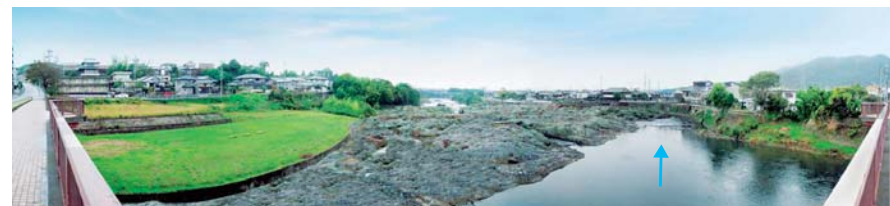
現在の闘龍灘の状況（闘龍橋より）
