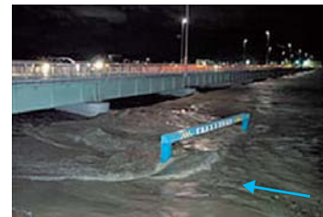
平成16年台風第23号による出水状況 加古川大橋（加古川5.5k付近）
