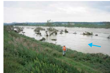
洪水時の河道内樹木（加古川 26.0k 付近）
