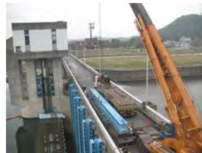
加古川大堰修繕工事
