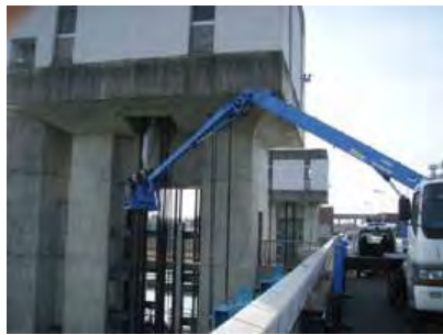
加古川大堰点検
