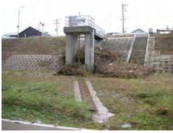
外新田樋管（左岸 5.1k 付近）
