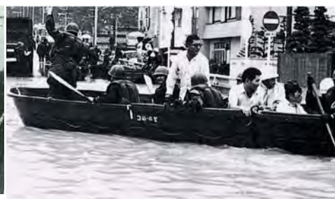
高砂市の浸水状況
