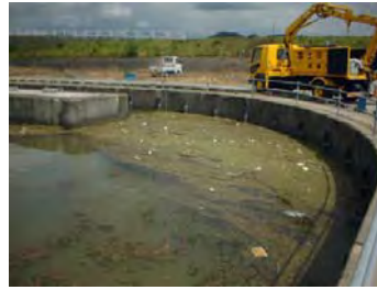
塵芥処理状況(加古川大堰)
