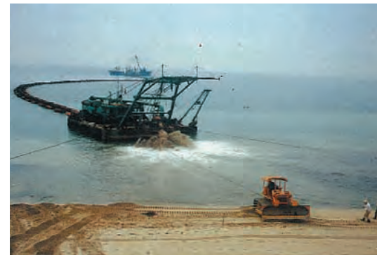
水中部施工状況
