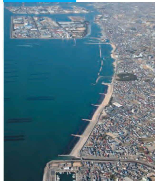
東播磨港～江井ヶ島港 (26.0km～19.0km付近)
