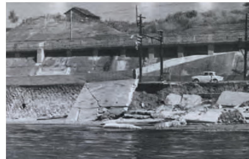
昭和39年20号台風で崩壊した護岸（神戸市垂水区舞子地先）
