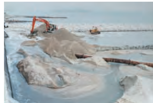
陸上部施工状況
