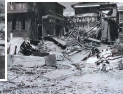
昭和39年20号台風で倒壊した家屋（神戸市垂水区舞子地先）
