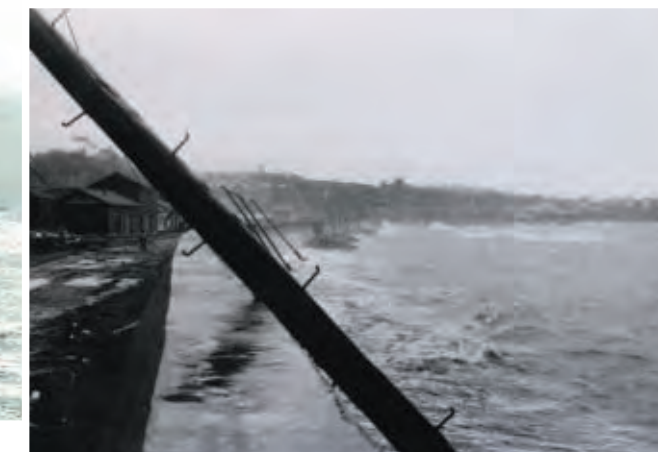
昭和39年20号台風で倒壊した電柱（神戸市垂水区狩口地先）
