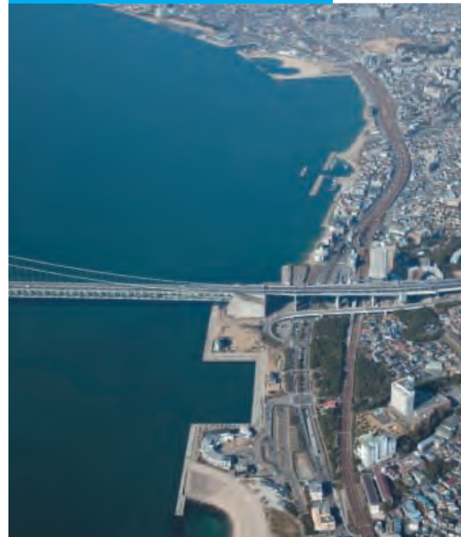
舞子漁港西側付近～明石海峡大橋 (7.5km～5.5km付近)
