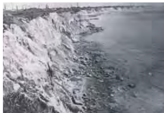
昭和33年西八木地先(無対策状態)
