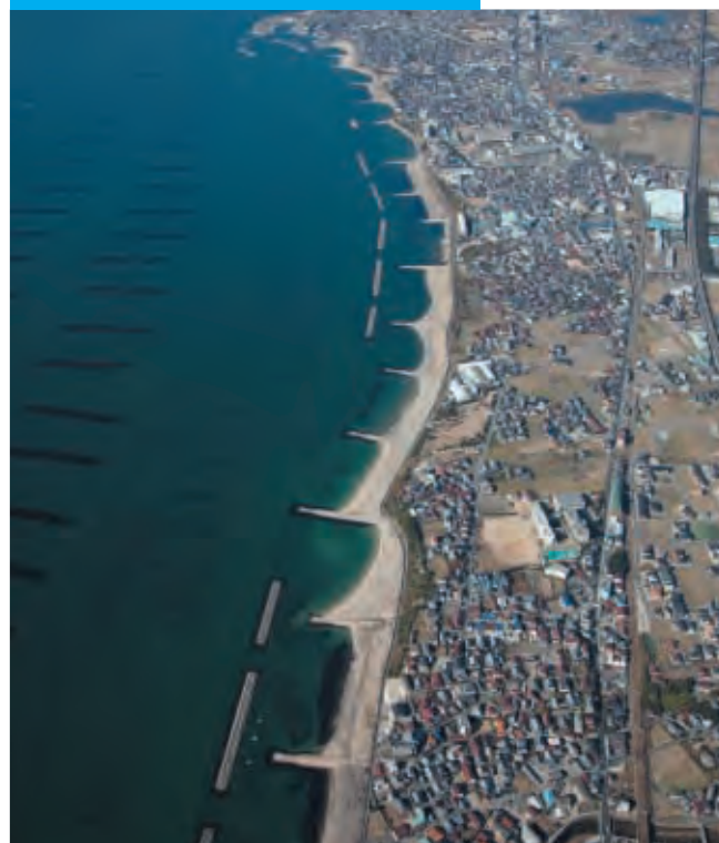
江井ヶ島港付近～藤江漁港付近 (19.0km～15.0km付近)
