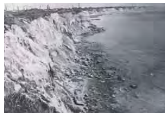
昭和33年西八木地先(無対策状態)
