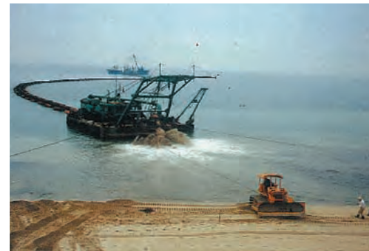
水中部施工状況
