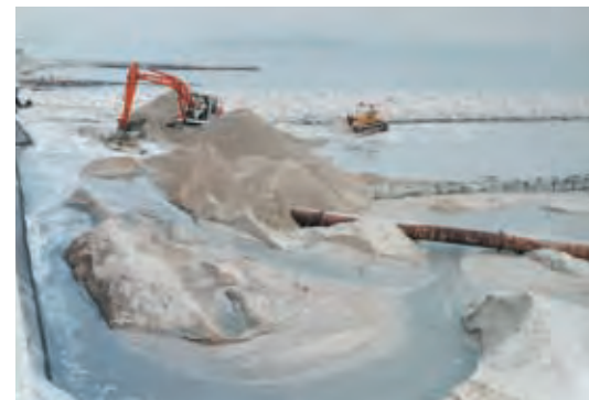
陸上部施工状況
