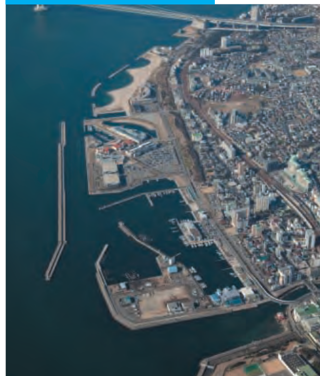
アジュール舞子付近～垂水漁港 (5.5km～3.5km付近)
