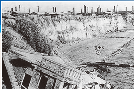
浸食で倒壊したタコ壺工場 (明石市江井島/昭和39年頃)
