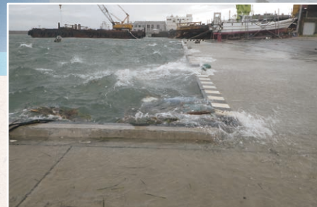
岸壁を超える高潮 (明石西外港/平成30年台風21号)
