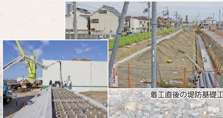
堤防天端へのコンクリート打設
