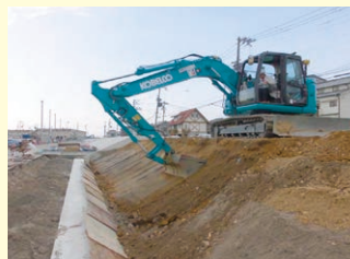
着工直後の堤防基礎工
