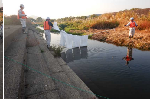
万国旗型オイルマットの設置訓練
