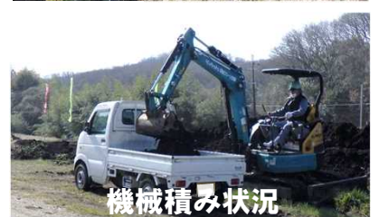
伐採木積み込み
