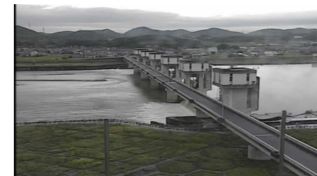
19日 16:20 洪水体制解除時状況
