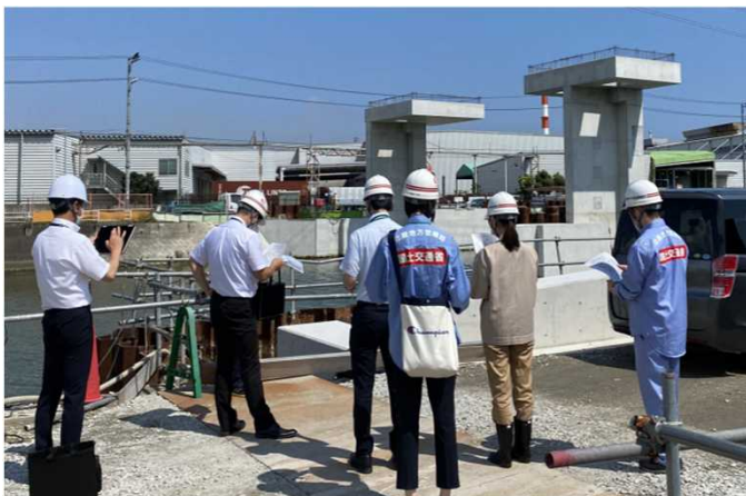
松村川排水機場及び防潮水門建設現場
