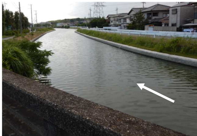
松村川河床掘削部
