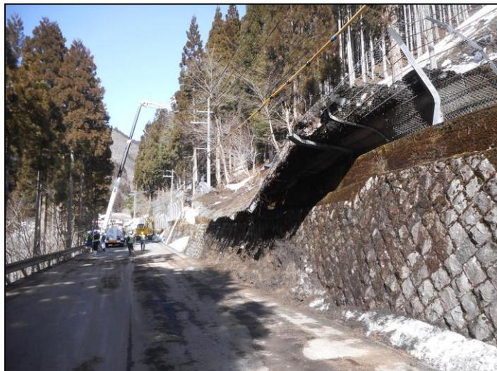
復旧作業状況（壊れた防護柵撤去）3月18日
