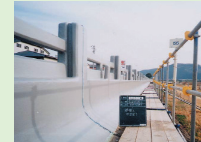
5.仕上げに耐久性を高める塗装をして工事完了
