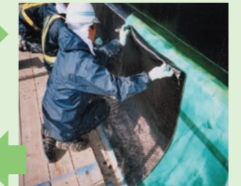
4.コンクリート劣化防止に炭素繊維シートを貼る
