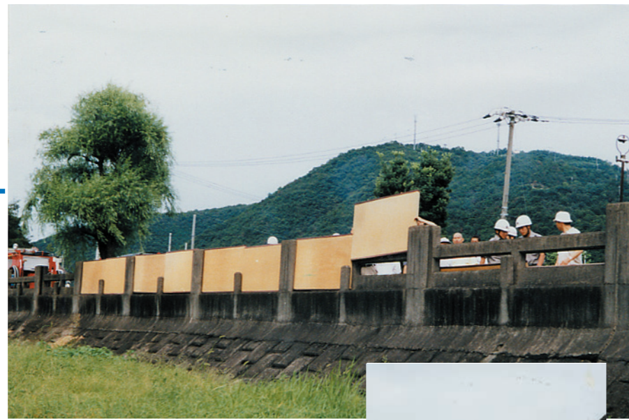
設置から50年。初の畳堤を使った水防訓練を行った消防隊員たち
