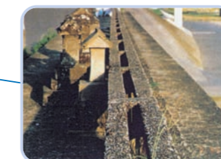
昭和初期に造られた日本で一番古い畳堤。延岡市五瀬川の900mの区域に設置されています 宮崎県
