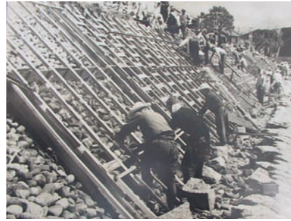
▲畳堤施工当時の新龍野橋付近での法覆い前の石積み作業
