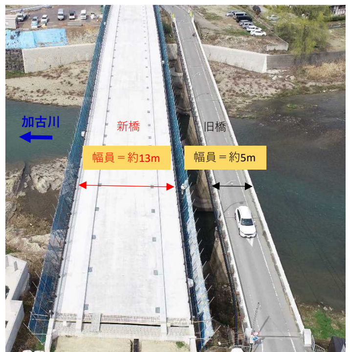
(左側)建設中の(新)滝見橋 (右側)(旧)滝見橋
