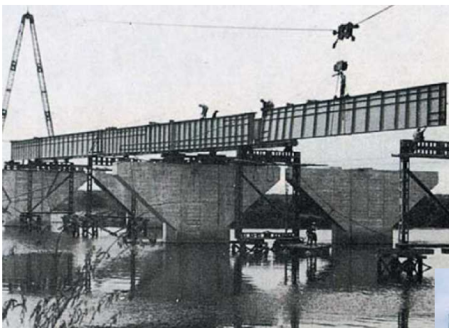
工事中的新加古川大橋
