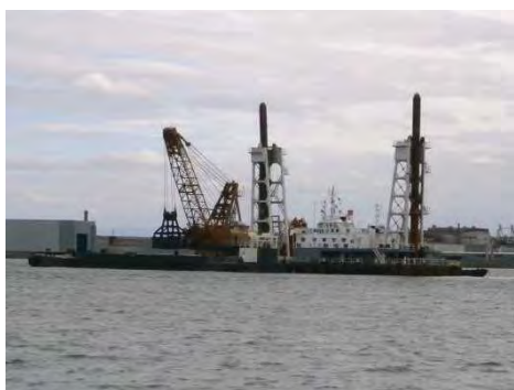
グラブ浚渫船(右)と土運船(左)
