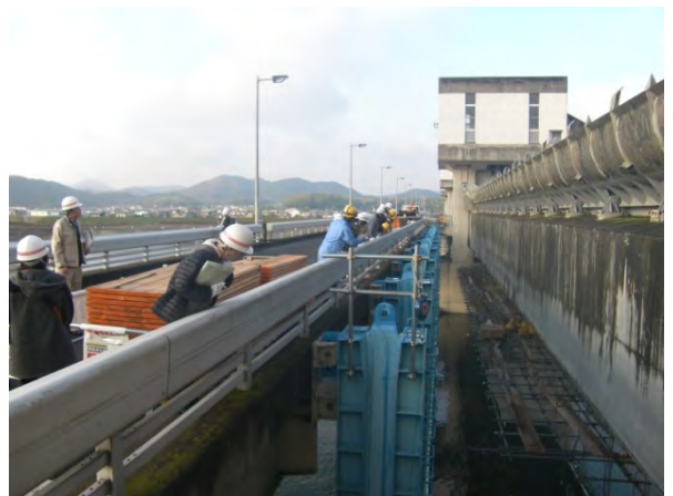
主ゲート(2号)修繕工事現場見学
