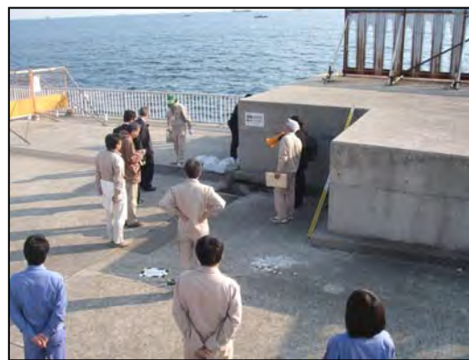
②コンクリート護岸背面の空洞調査 (明石市大蔵海岸)
