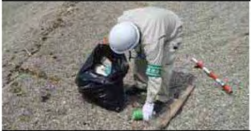
③護岸等の目視
