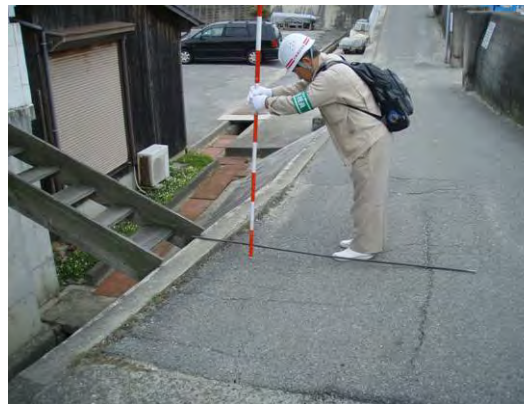
管理用道路陥没8.5cm 明石市谷八木付近 平成22年2月撮影
