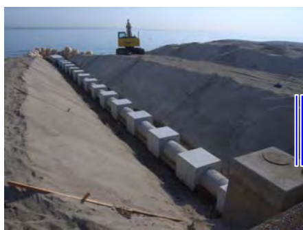
排水管継目補強
