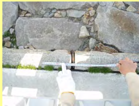
② ケーソンの開き測定(陸側)
