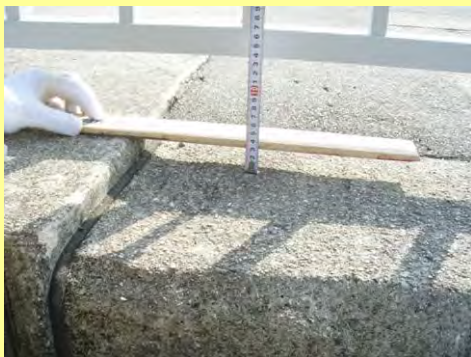
④ ケーソンの段差測定 明石市大蔵谷付近
