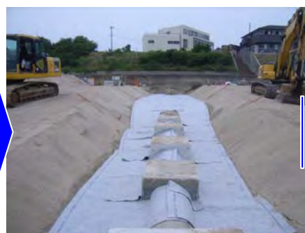
碎石・吸出防止材敷設
