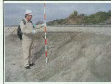
※3...養浜区間8-5(16.4km+120m付近) 波浪による浸食を確認。H=100cm
