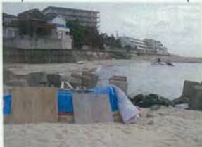
※2...養浜区間7(18.6km~100m~ 18.6km+30m付近) 12/26報告の調査箇所を鉄筋貫入により再 確認。...異常なし。
