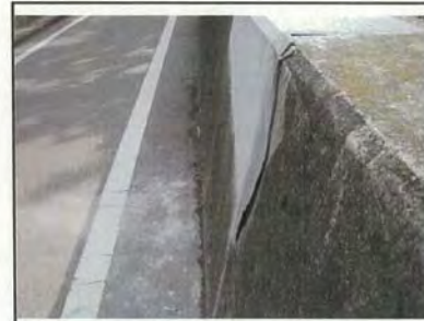
※7...養浜区間21(13.2km~50m付近) クラック補修箇所でもルタルの剥離及び理 きを確認。
