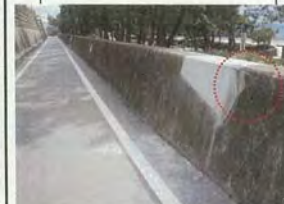
※7...養浜区間21(13.2km~50m付近) クラック補修箇所でもルタルの剥離及び理 きを確認。
