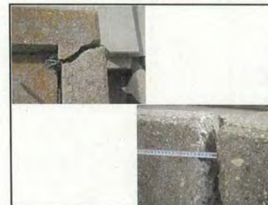
※8...1.0km~40m付近 管理用通路の擁壁の開き再確認。L=2.1m 開き35mm
