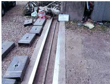
戸当り堆積土砂撤去
