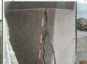
※8...1.0km~40m付近 管理用通路の擁壁の開き再確認。L=2.1m 開き35mm
