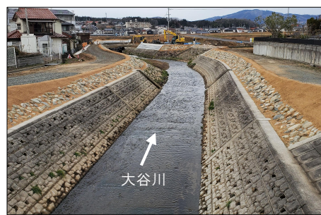
広島県による支川の改修
