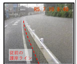
<池町川護岸嵩上げ>
