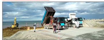
養浜材の荷下・投入状況 (R4.8.18 撮影)
