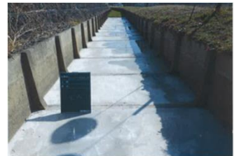
底張りコンクリート
