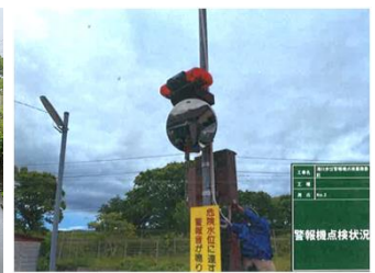
竜川水位警報機点検
