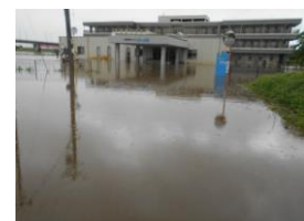
浸水時の状況 (喜多方市提供)
