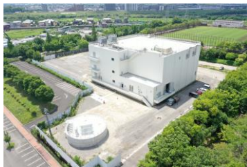
雨水ポンプ場
