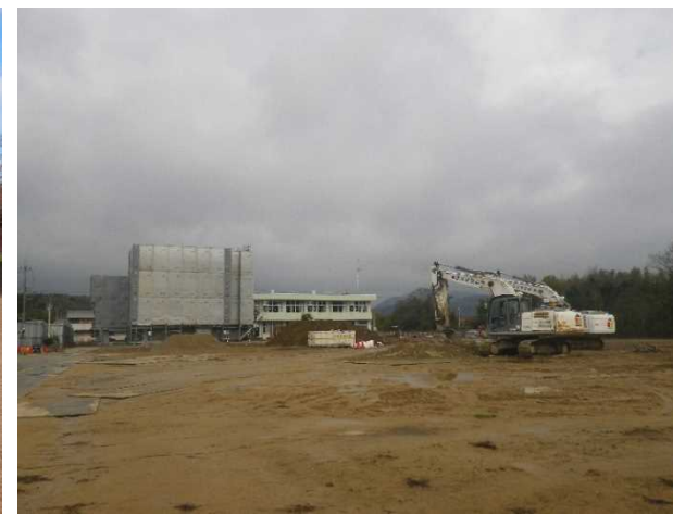
旧東条東小学校工事の様子
