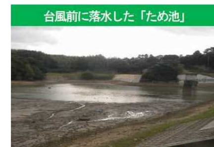
(H26.10 淡路市志筑 黒田池)
