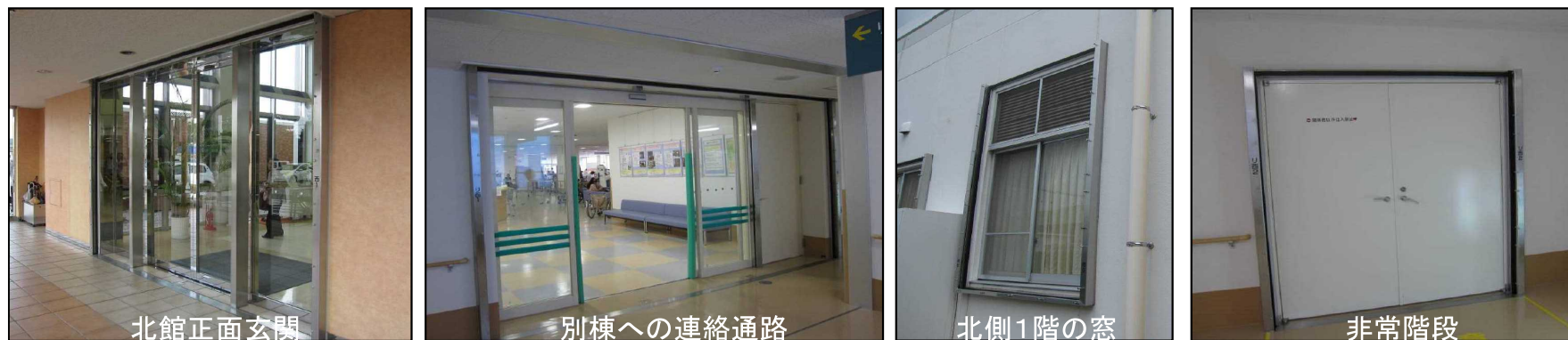
止水板のための角落しとの設置
