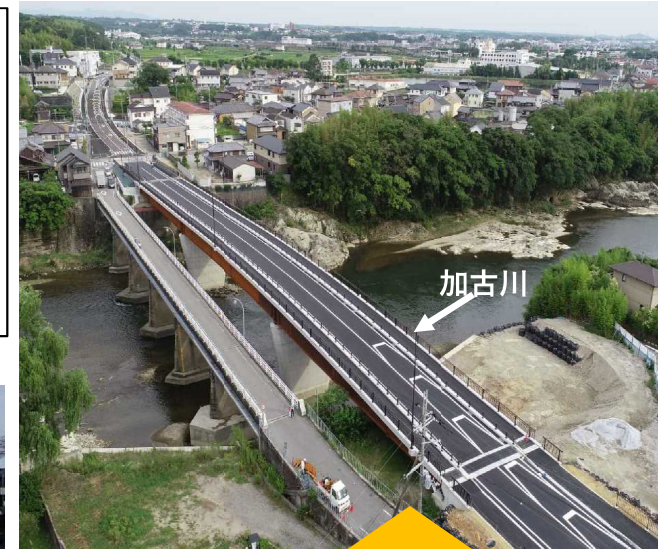
加古川 滝見橋完成 R2.7供用開始
