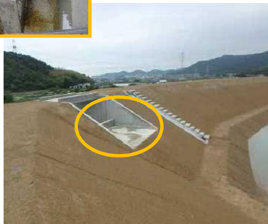
大池(緊急放流工)※工事中の様子
