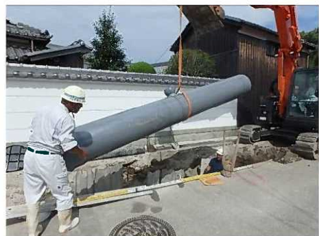
(管埋設の様子)
