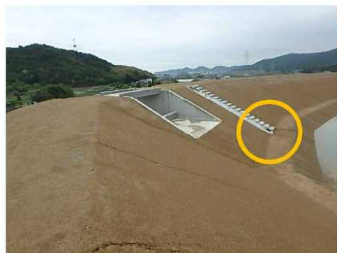
大池(緊急放流工)※工事の様子
