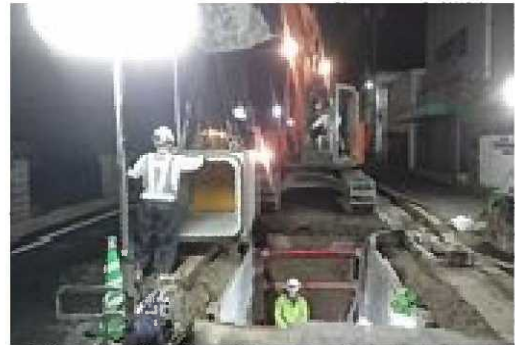
(函渠埋設(夜間作業)の様子)
