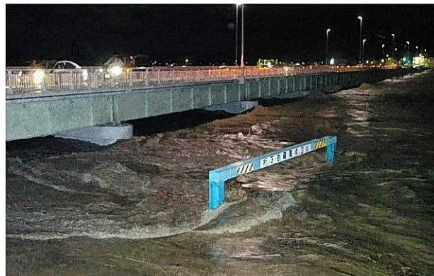
国道2号 加古川橋の状況(第23号)
