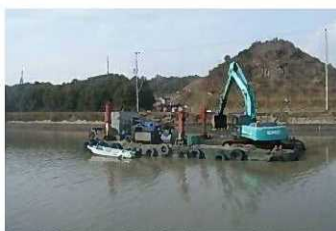
各工事の様子(左:河床掘削、中:ブロック積護岸、右:矢板護岸)
