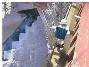
各工事の様子(左:河床掘削、中:ブロック積護岸、右:矢板護岸)
