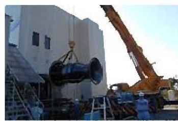
⑦天川ポンプ場(増設)
