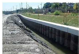
各工事の様子(左:河床掘削、中:ブロック積護岸、右:矢板護岸)
