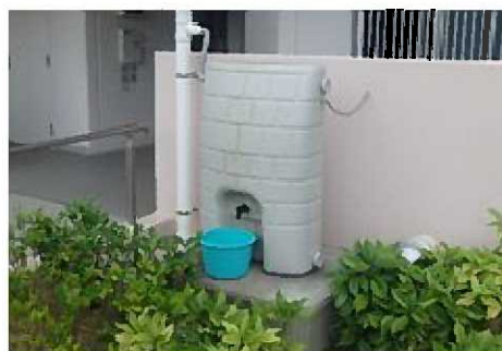
中筋市営住宅(貯留タンク)
