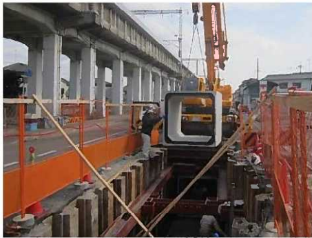
(函渠埋設の様子)
