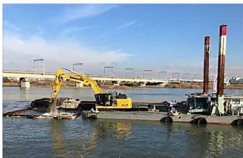
浚渫工事の様子
