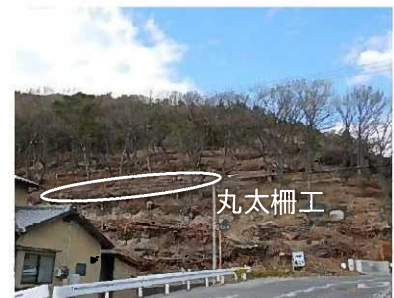
里山防災林整備状況(北脇地区)
