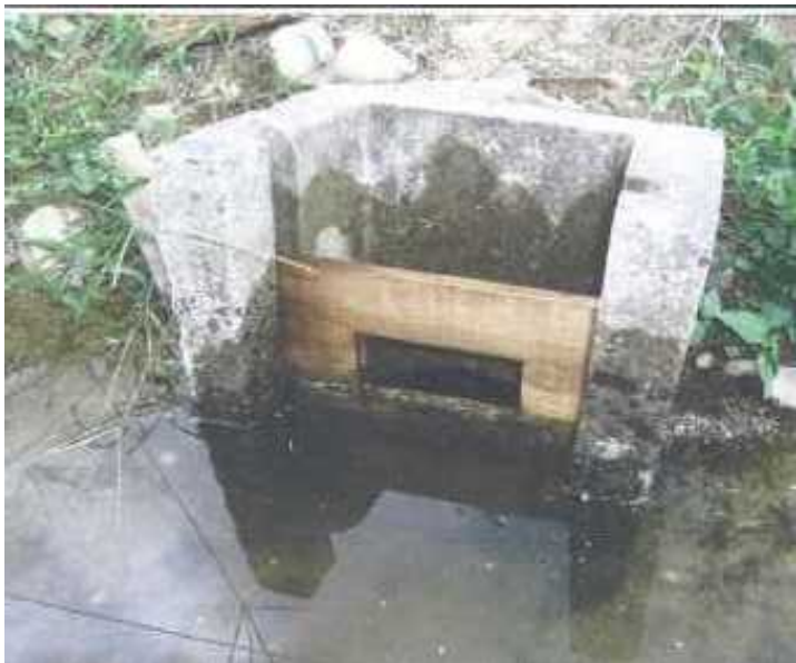
落水口に設置したせき板
