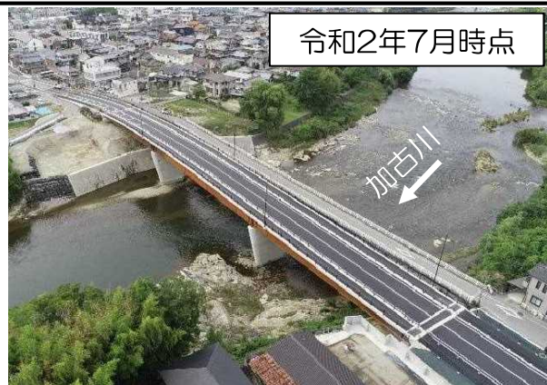
流下能力向上のための橋梁改築 (加東市)
