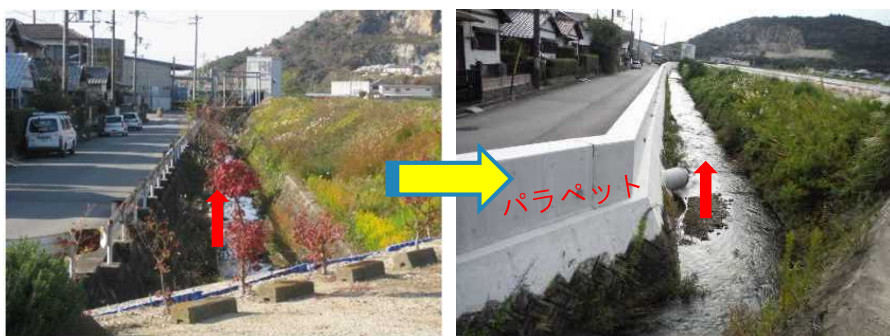
輪中堤による浸水対策(加古川市)
