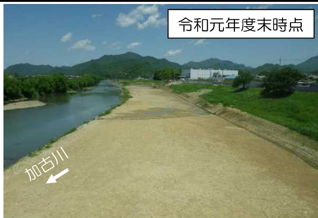
河道掘削 (西脇市)
