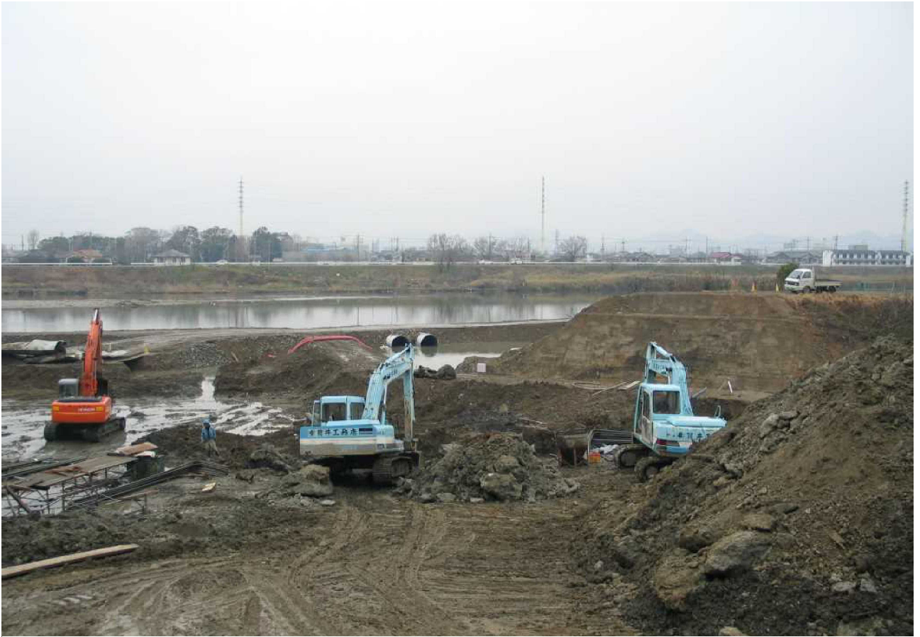
兵庫県市川下流における河川改修工事
