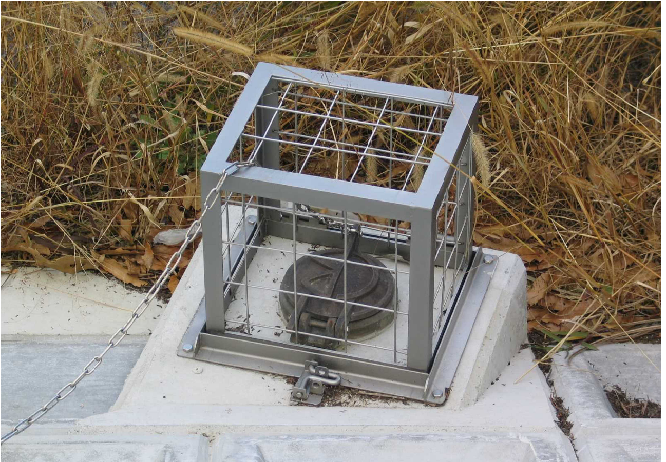
兵庫県淡路市・宮池の放流管
