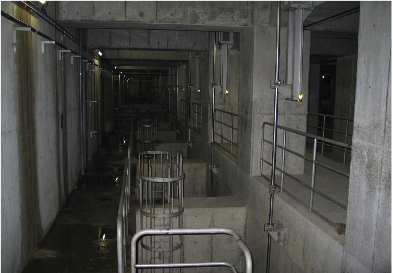
松原南調整池(寝屋川流域)
