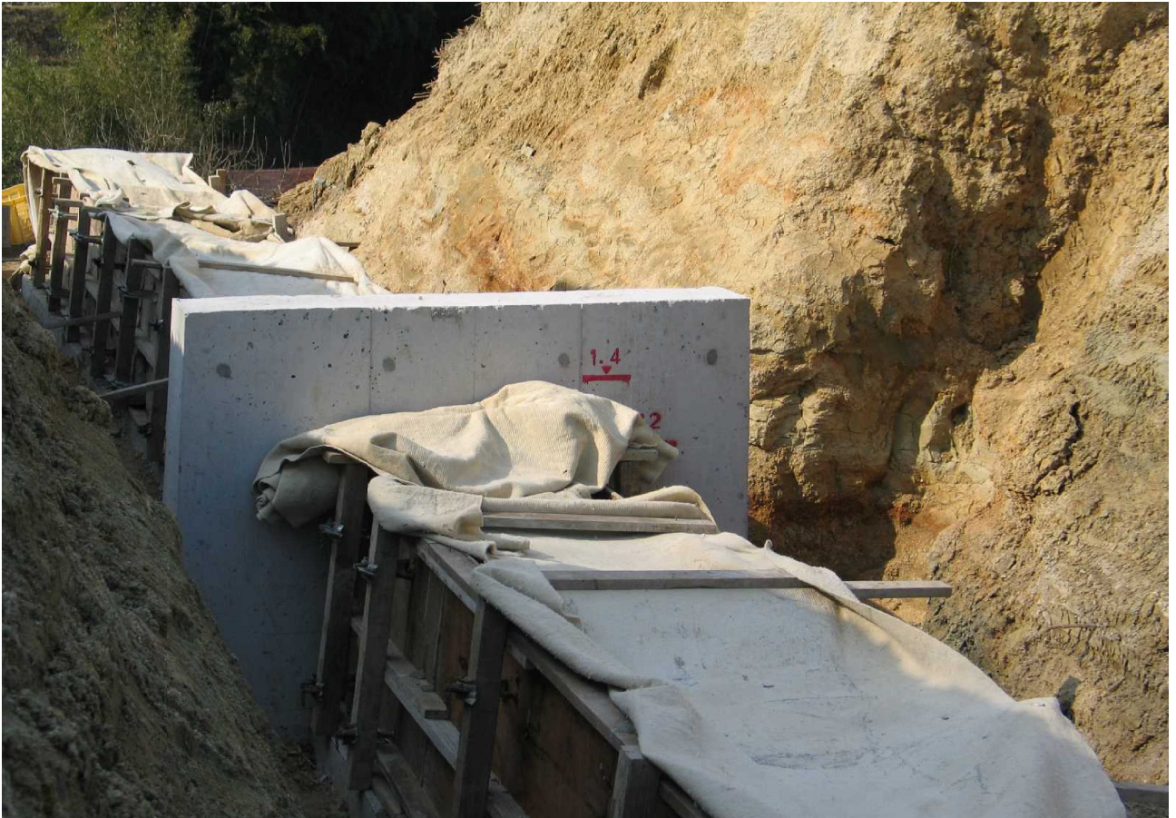
安乎堂池(淡路市)における放流管の設置工事
