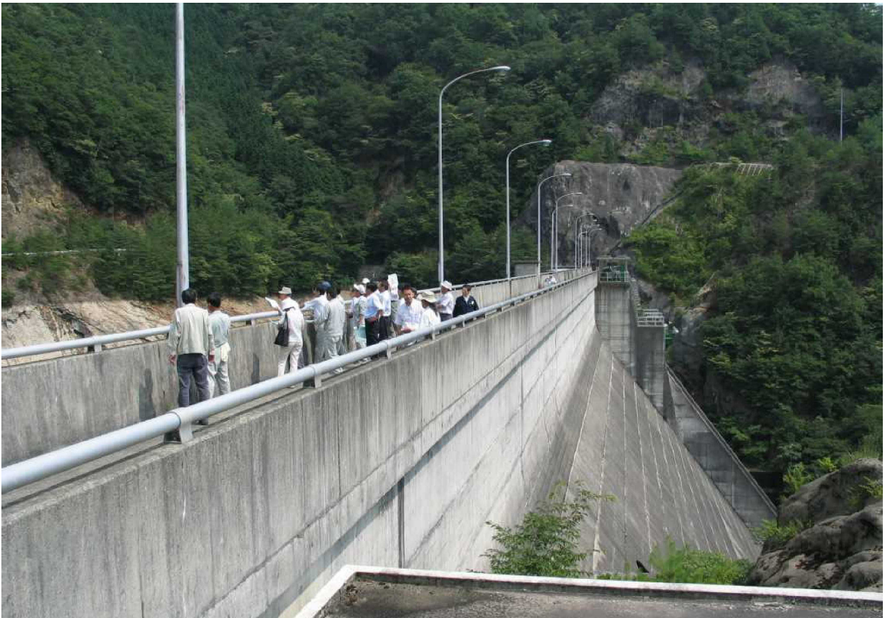
兵庫県市川上流の生野ダム(洪水調節容量を有する多目的ダム)
