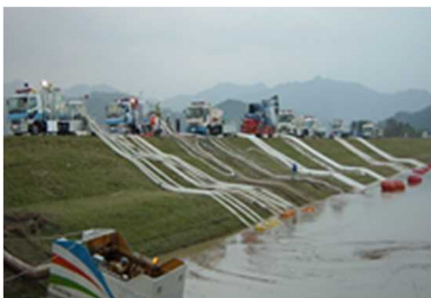
排水ポンプ車による緊急排水
