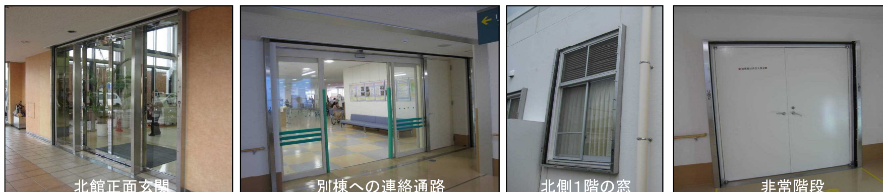
止水板のための角落し設置
