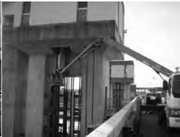
加古川大堰点検の様子
