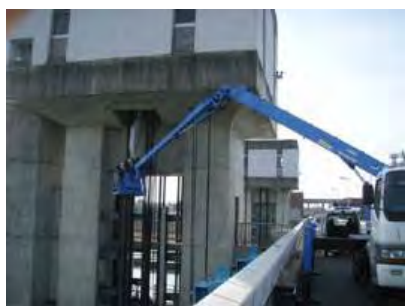
加古川大堰点検
