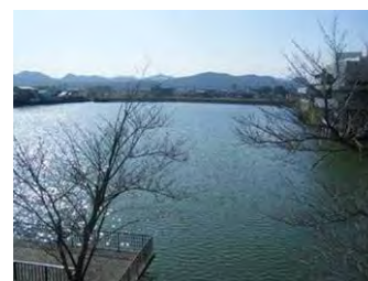
図-2.3.15 ため池 (大池：小野市)
