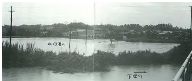
加西市の浸水状況
