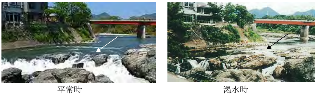
図-2.2.3 平成6年渇水時の状況（闘龍灘付近 35.0km 付近）
