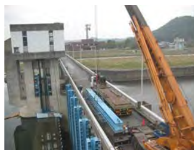
加古川大堰修繕工事
