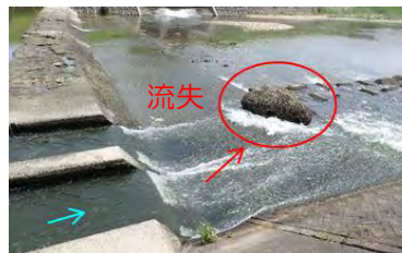
阿形井堰魚道付近の状況 (現状では通水部には落差があり、水生生物の遡上は困難)
