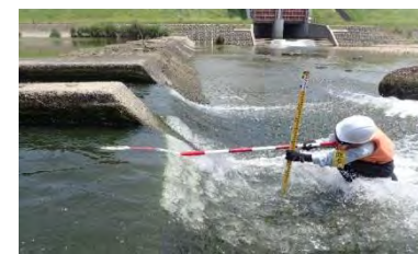
阿形井堰魚道付近の状況 (現状では通水部には落差があり、水生生物の遡上は困難)
