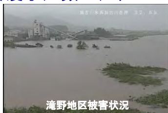
滝野地区被害状況
