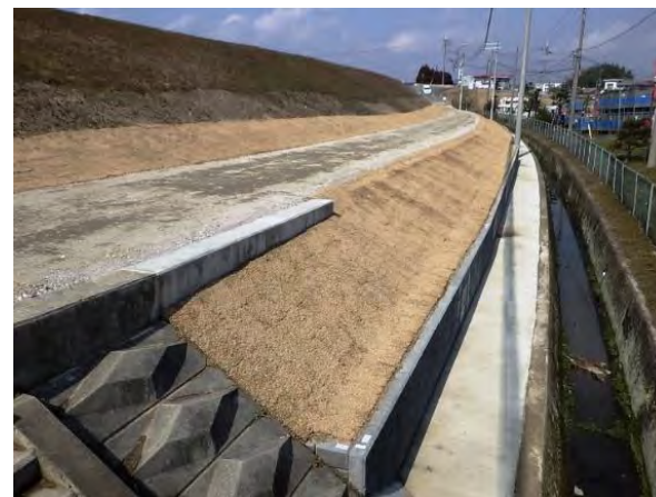
浸透対策（万願寺川；小野市粟生地区）
