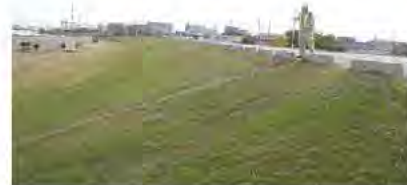
平成24年度 堤防点検実施状況
