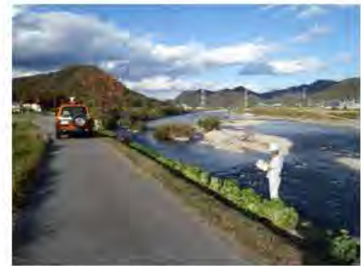
平成24年度 堤防巡視実施状況
