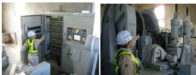
加古川大堰の点検状況
