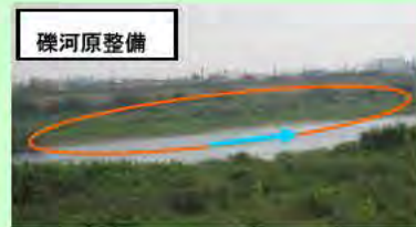
(大野地区 礫河原の整備)
