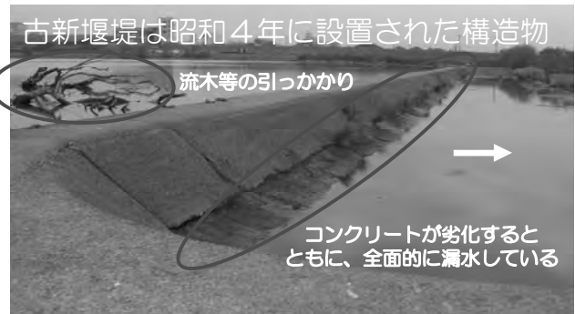
老朽化した堰（古新堰堤）
