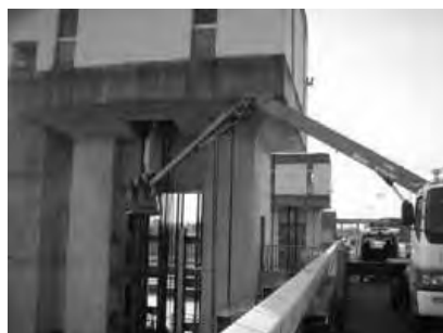
加古川大堰点検
