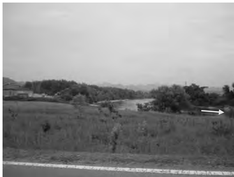
堤防が無い区間（加東市）
