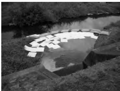
水質事故対応 (オイルフェンスの設置)
