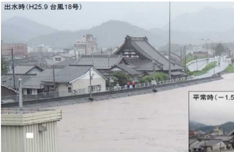
平成25年台風18号 福知山市街付近の堤防の様子
