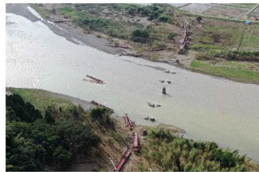
くま川鉄道 球磨川第4橋梁 橋梁流失 (熊本県球磨郡相良村-錦町)
