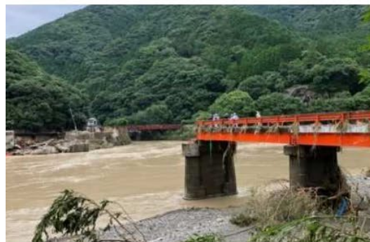
県道小鶴原女木線 深水橋 橋梁流失 (熊本県八代市)
