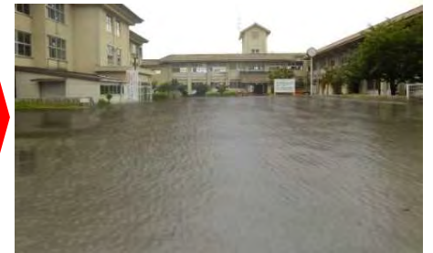
〇〇小学校 浸水後 (1.2m)
