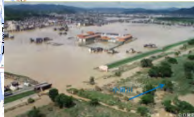
左岸3k400破堤状況
